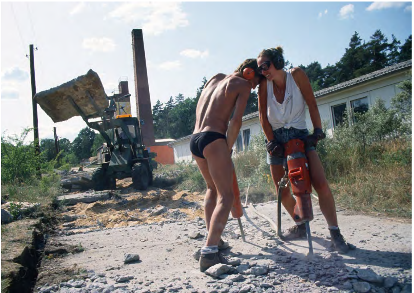
Baustelle auf dem Gelände
