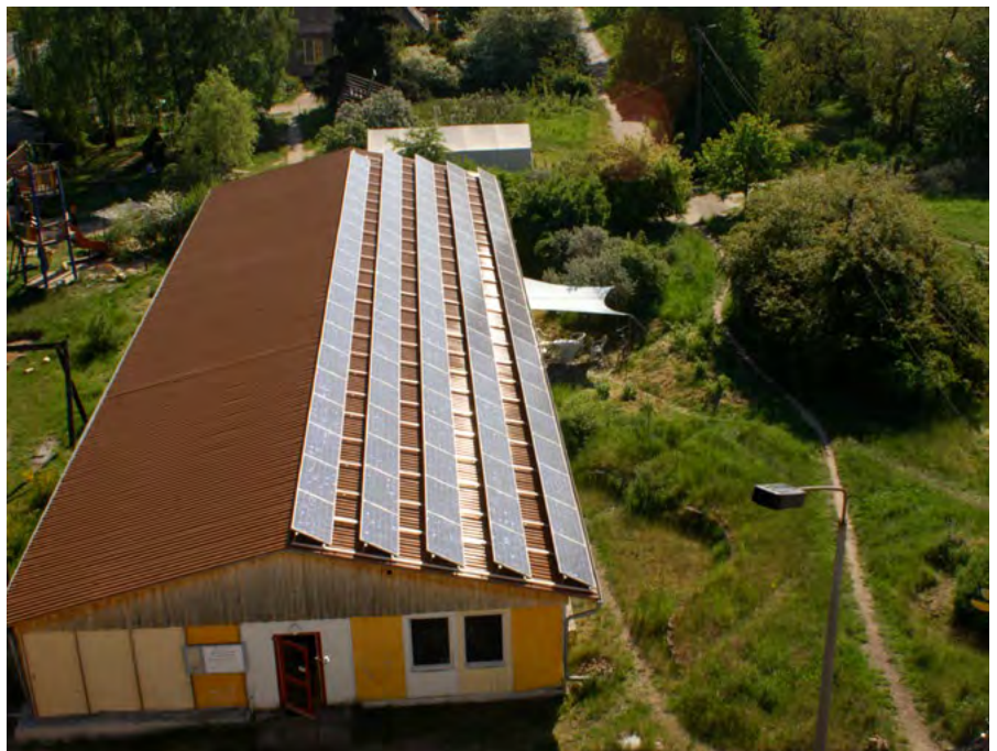
Die Photovoltaikanlage des ZEGG
